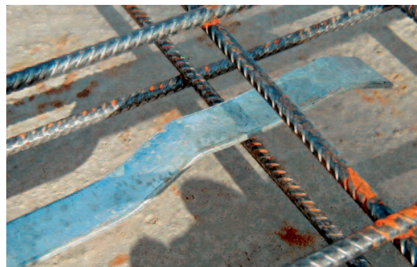
Bild 3: Das Biegen des Bandes eiserleichtert die Verlegung zwischen den Bewehrungsmatten oder Armierungsstäben
