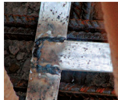
Bild 6: Geschweißte stromtragfähige Verbindung – die Naht soll mindestens 30 mm lang und 3 mm dick sein
