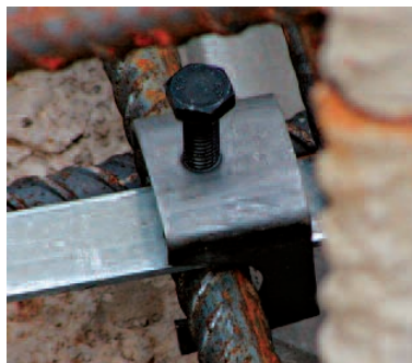
Bild 5: Stromtragfähige Verbindung mit Klemme – Keilverbindungen eignen sich hierfür nicht
